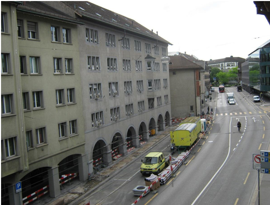
Installation / Startschacht Microtunnel Neumarkt - Bahnhofplatz
